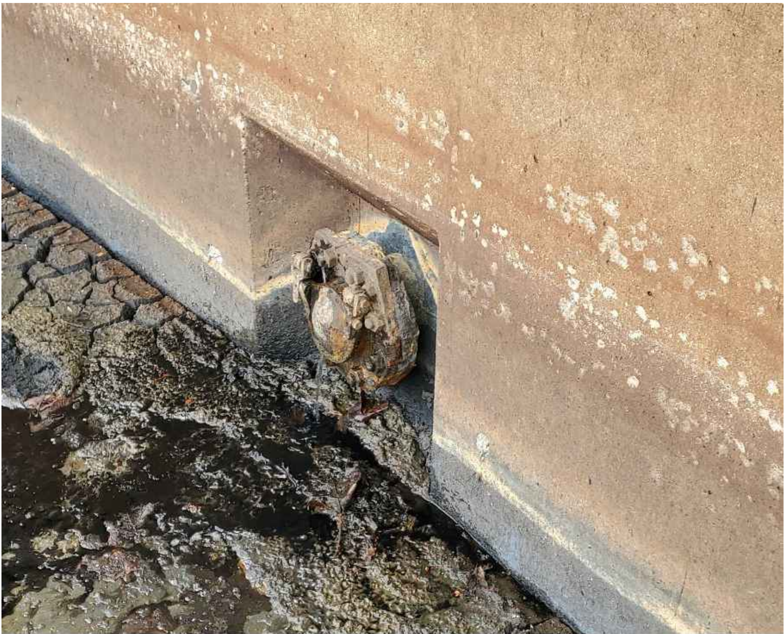
PRESSURE RELIEF VALVE SCALE: NONE
